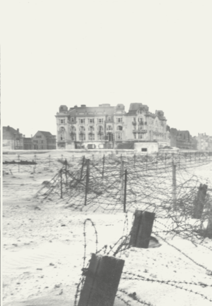
Figuur 19: Schade met o.a. de afgeplatte daken, geamputeerde toren, beschadigde gevels en ramen en vernietiging van de loggia (1946)
